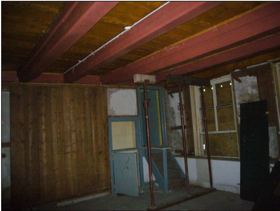
Afbeelding 14 –middelste voorkamer boerderij, woonhuisgedeelte, met zicht op de opstap naar de opkamer en het luik naar de kelder met kruisgraatgewelf
