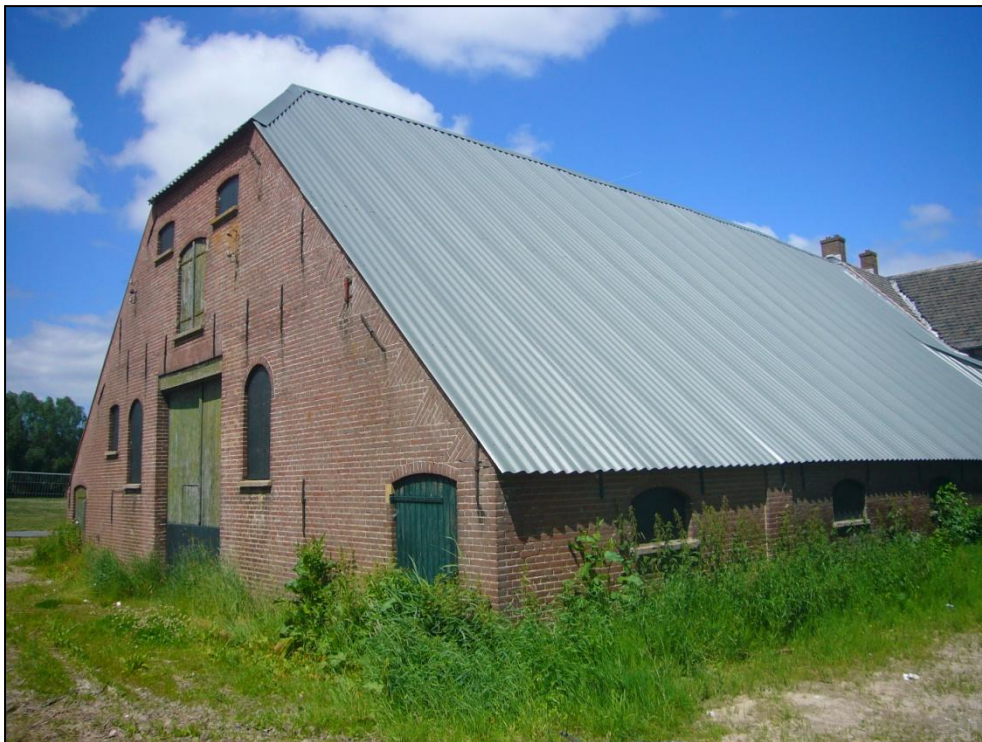
Afbeelding 10 – zuidelijke kopgevel en oostelijke langsevel stalgedeelte
