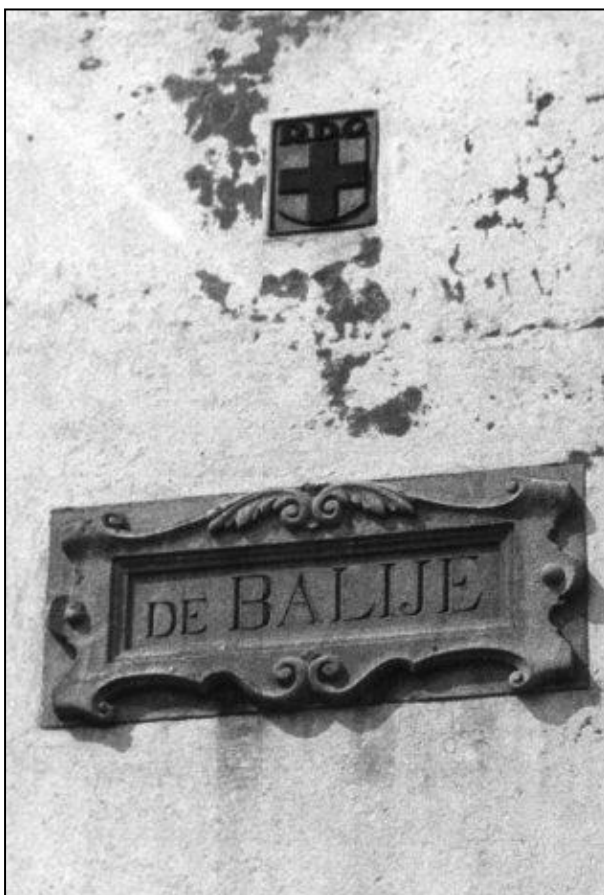
Afbeelding 7 –gevelsteen van de boerderij waarop DE BALIJE, daarboven een kleinere gevelsteen met RDO (Ridderlijke Duitse Orde).
