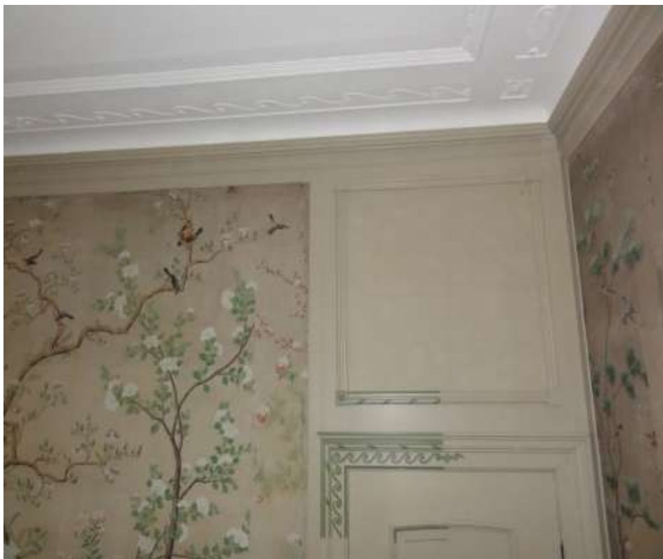
Afb. 3 Salon 1.5, zomer 2010, met gereconstrueerde polychromie.
